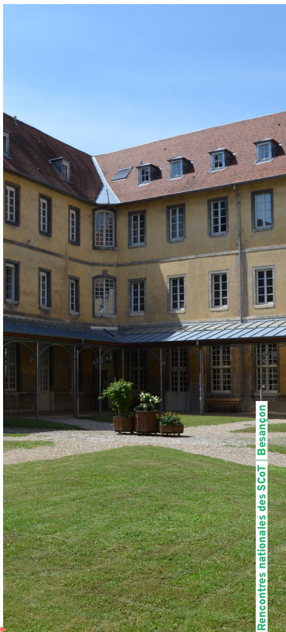
L'espace Grammont, cour intérieure, Besançon
